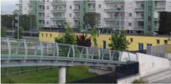
Ponte pedonale esistente su via Campopannone
